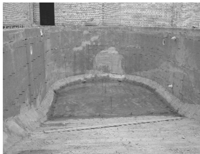
Рис. 1. Устройство гидроизоляции бассейна
