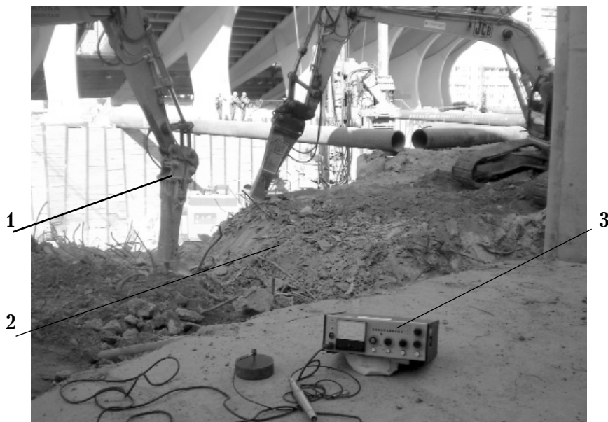
Рис. 4. Руйнування ростверка освітлювальної опори в осях 480-490 двома екскаваторами з гідро молотами: 1 – гідромолот на базі екскаватора; 2 – ростверк фундаменту освітлювальної опори №1; 3 – вимірювач вібрації ВШВ-003-М2.
