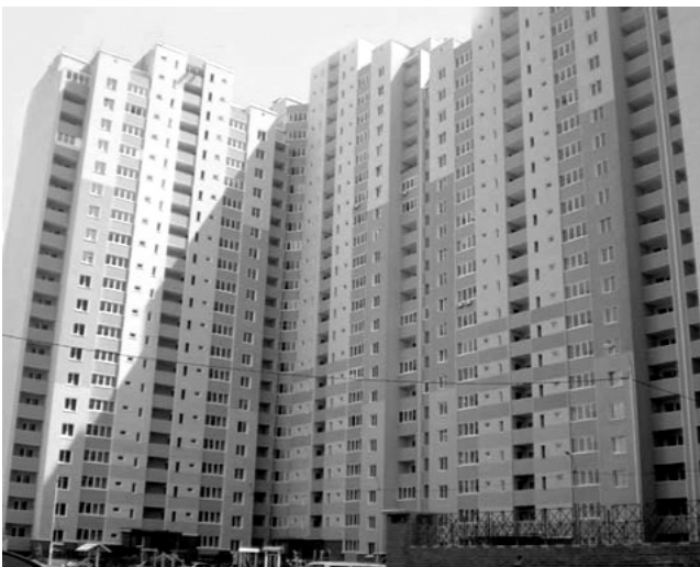
Рис. 1. Пятисекционный будинок нової модернізованої серії "АППС-К-134 М", який введено в експлуатації в листопаді 2010 року по вул. Закревського, 97 у м.Києві
