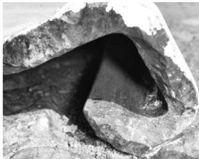
Рис. 5. Замок шпунтовой сваи после ее извлечения
