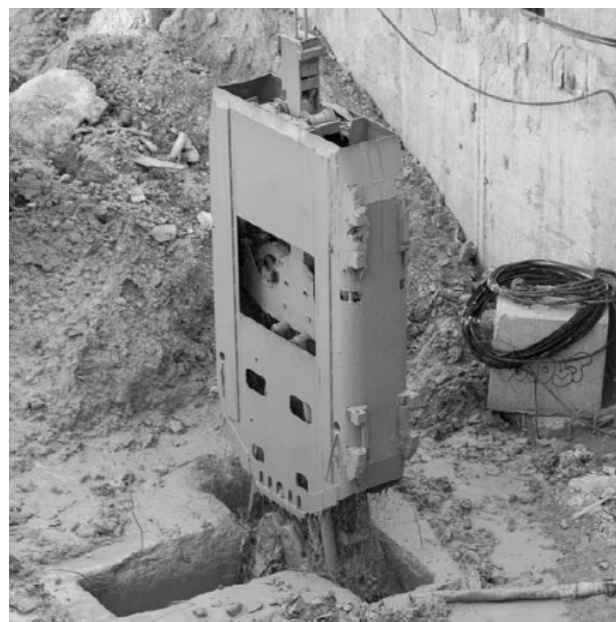
Рис.3 Устройство Т-образной барреты способом «стена в грунте» навесным канатным грейфером
